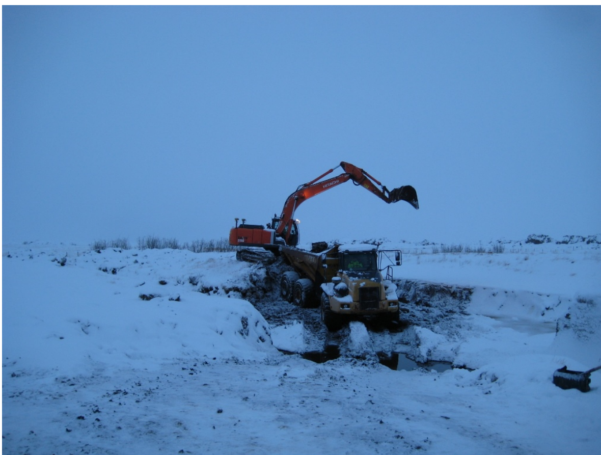
Mynd 4. Unnið við dýpkun og stækkun setgryfju í Fíflholtum 17. desember 2013. (Ljósm. S.G).
